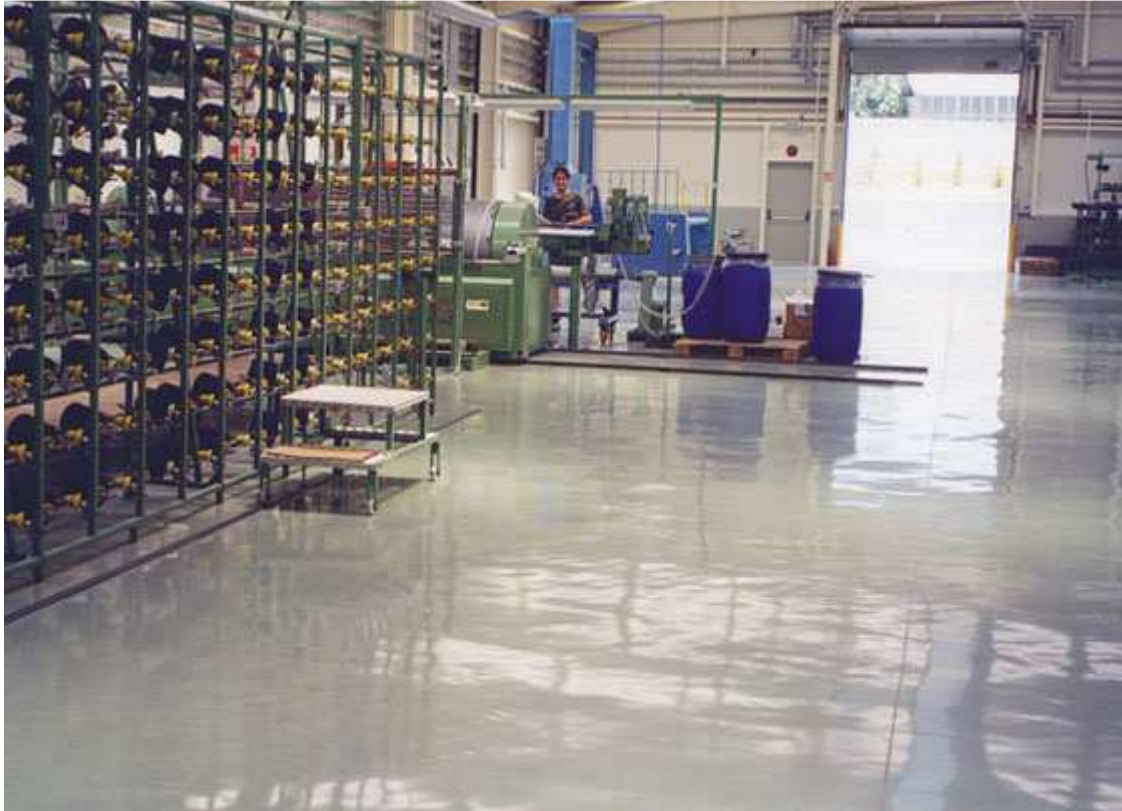
Саморазливен епоксиден под Durofloor, положен в текстилна фабрика.
