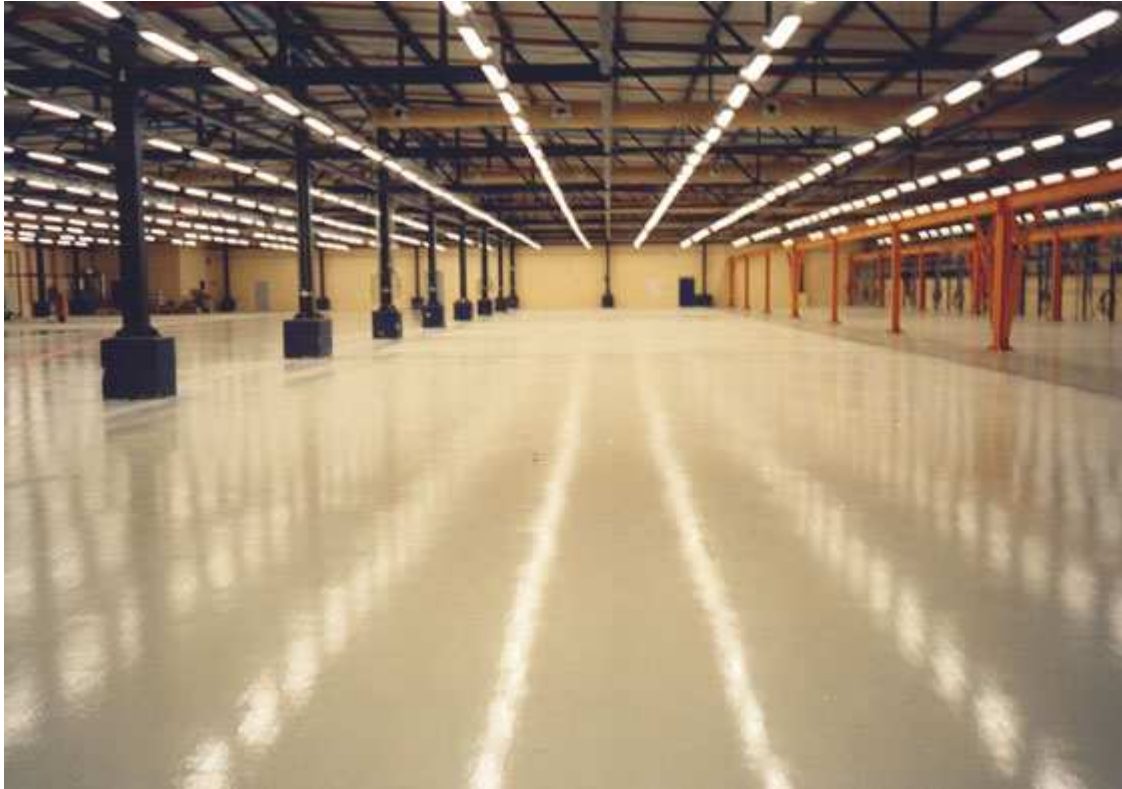
Тънкослойно епоксидно покритие Durofloor R, положено в склад на компанията ВИС.
