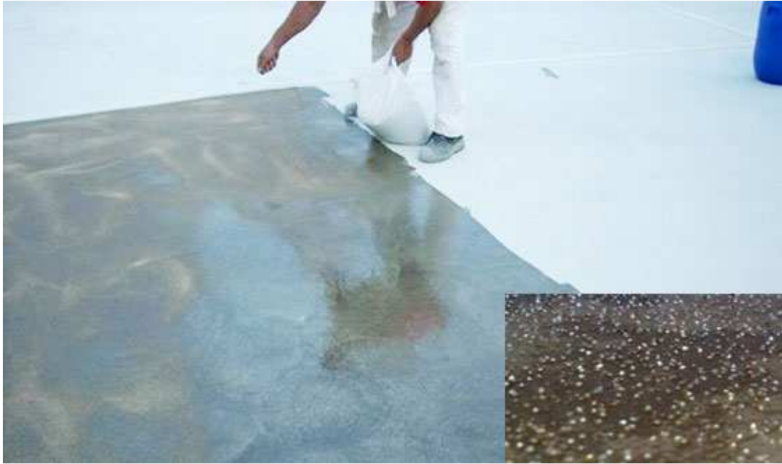
3. Полагане на замазки Sikafloor® Terrazzo (смола Sikafloor®-162 + цветен кварцов пясък):
