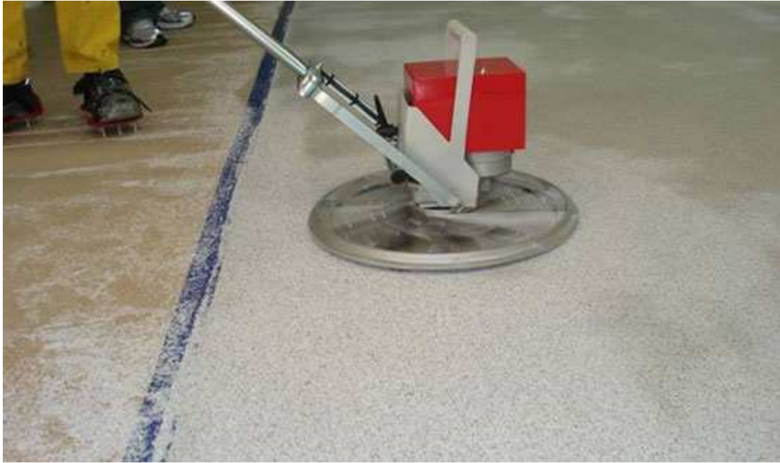
механизирано с електрическа пердашка 6. Импрегниране и запечатка със Sikafloor®-162:
