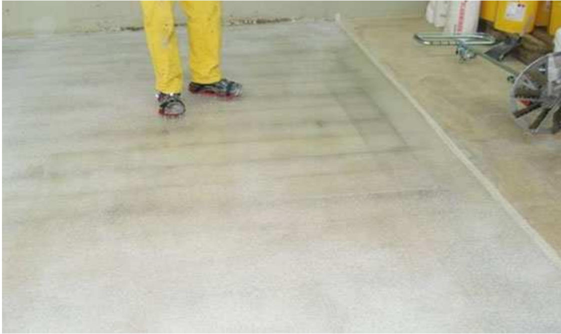
опесъчаване до насищане 5. Уплътняване и заглаждане:
